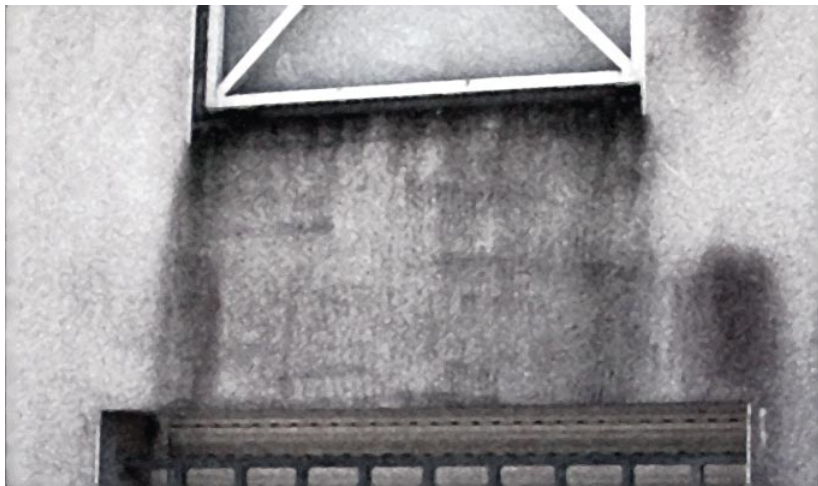
Apparition de micro-organismes sur une finition grattée.
